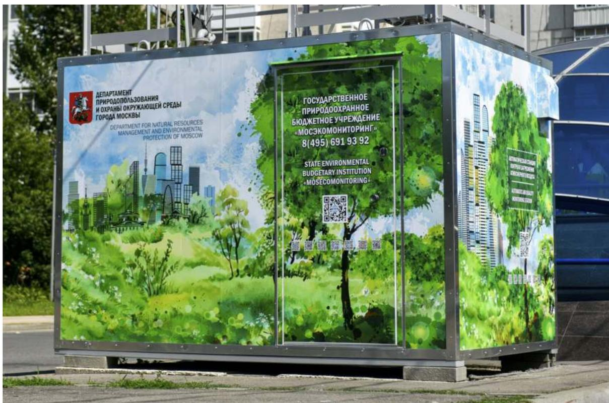
Рис. 2.1.1. Автоматическая станция контроля загрязнения атмосферы
