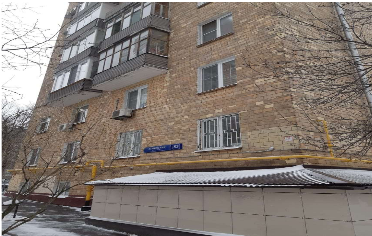
Фото 35. Общий вид фасада здания
