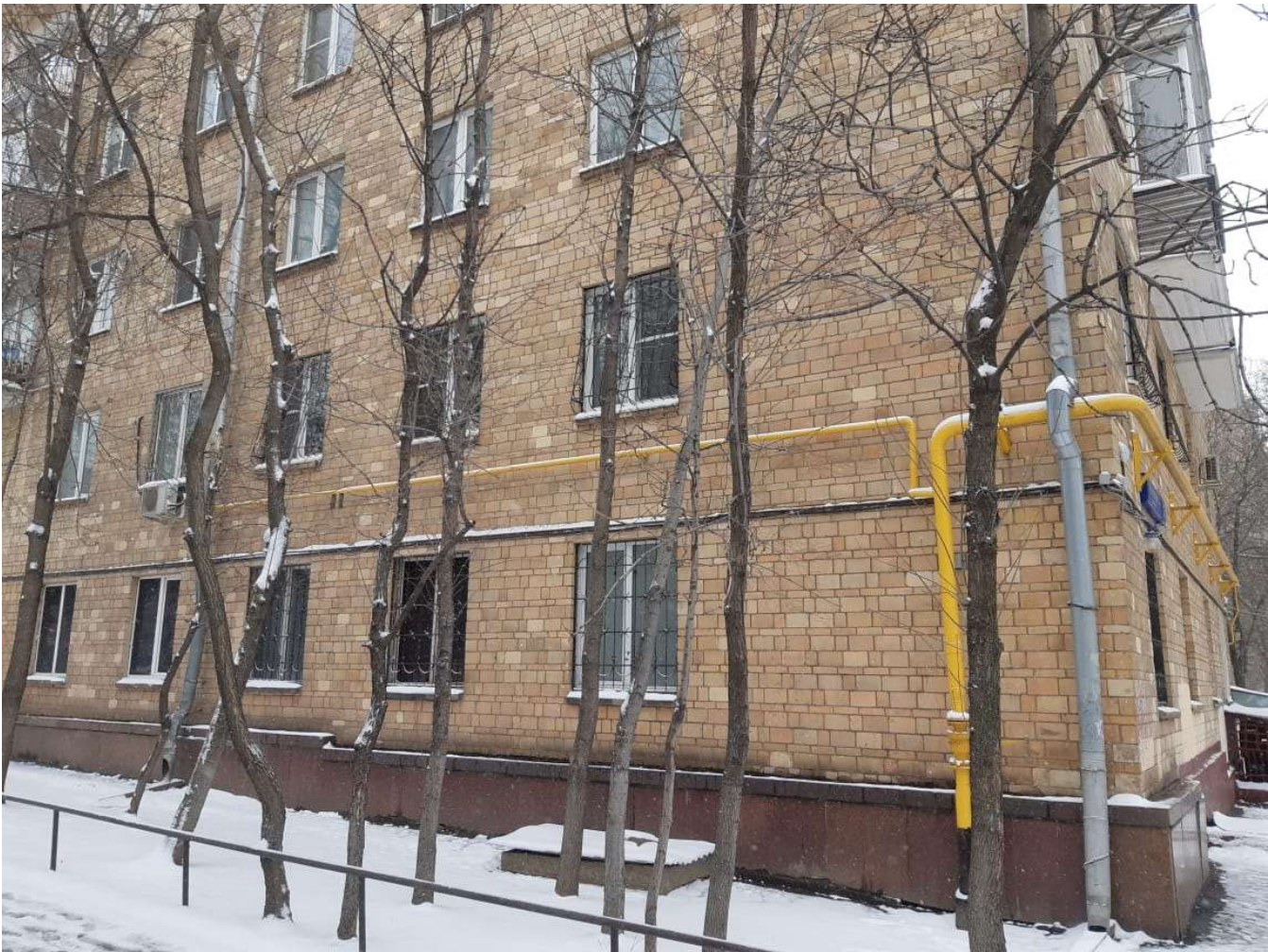
Фото 19. Общий вид фасада здания
