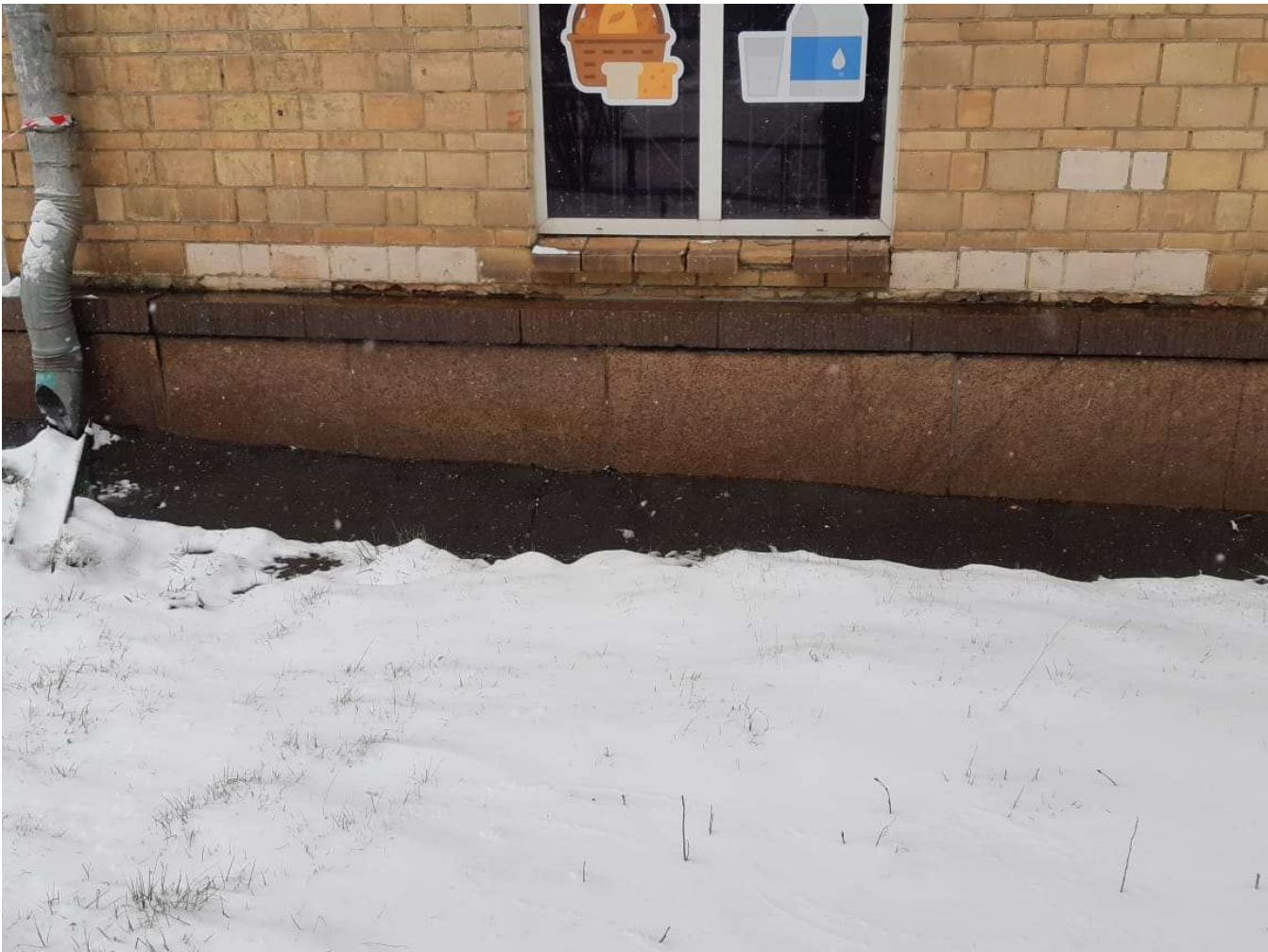
Фото 18. Общее состояние отмостки
