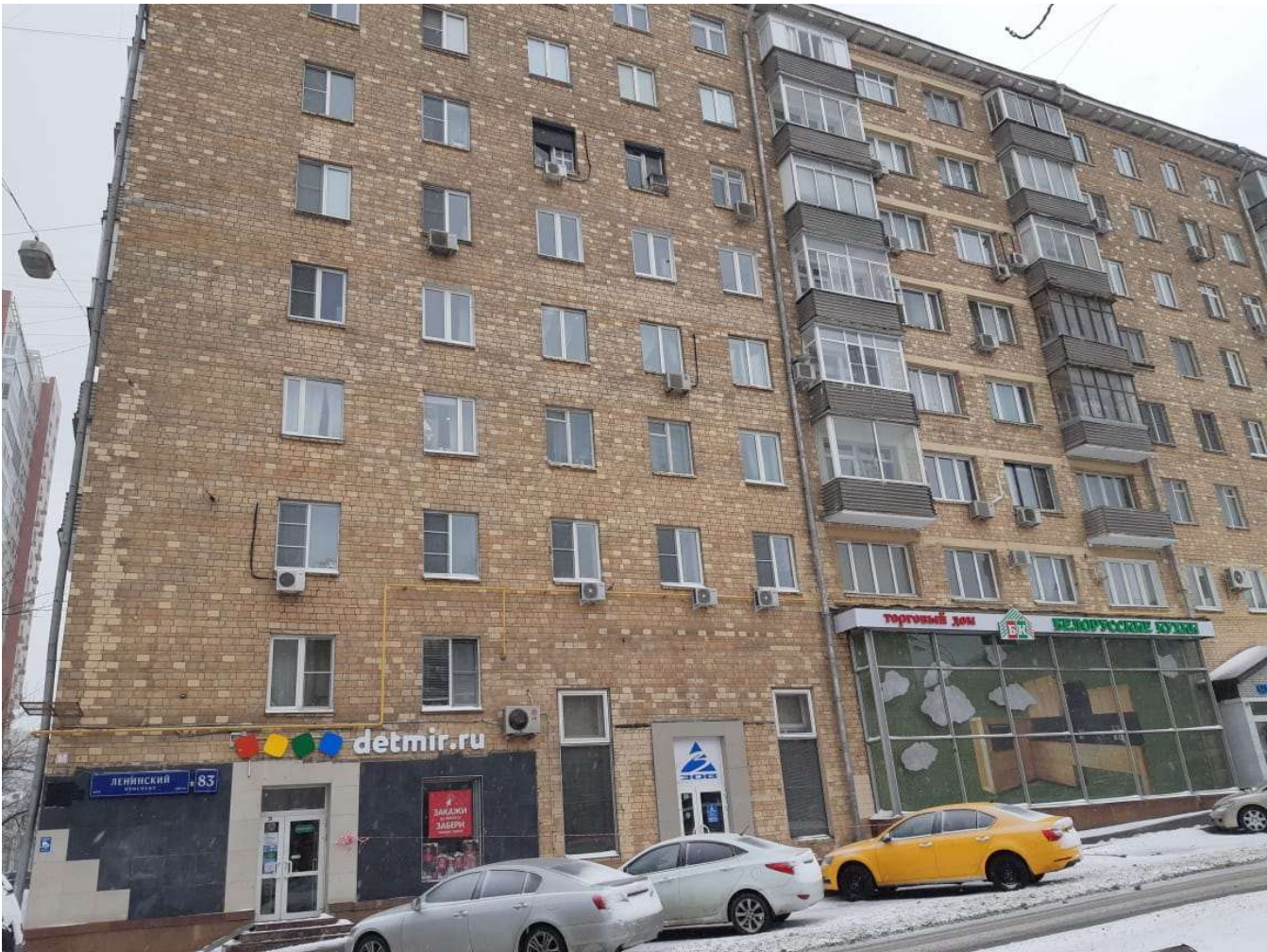
Фото 6. Общий вид фасада здания
