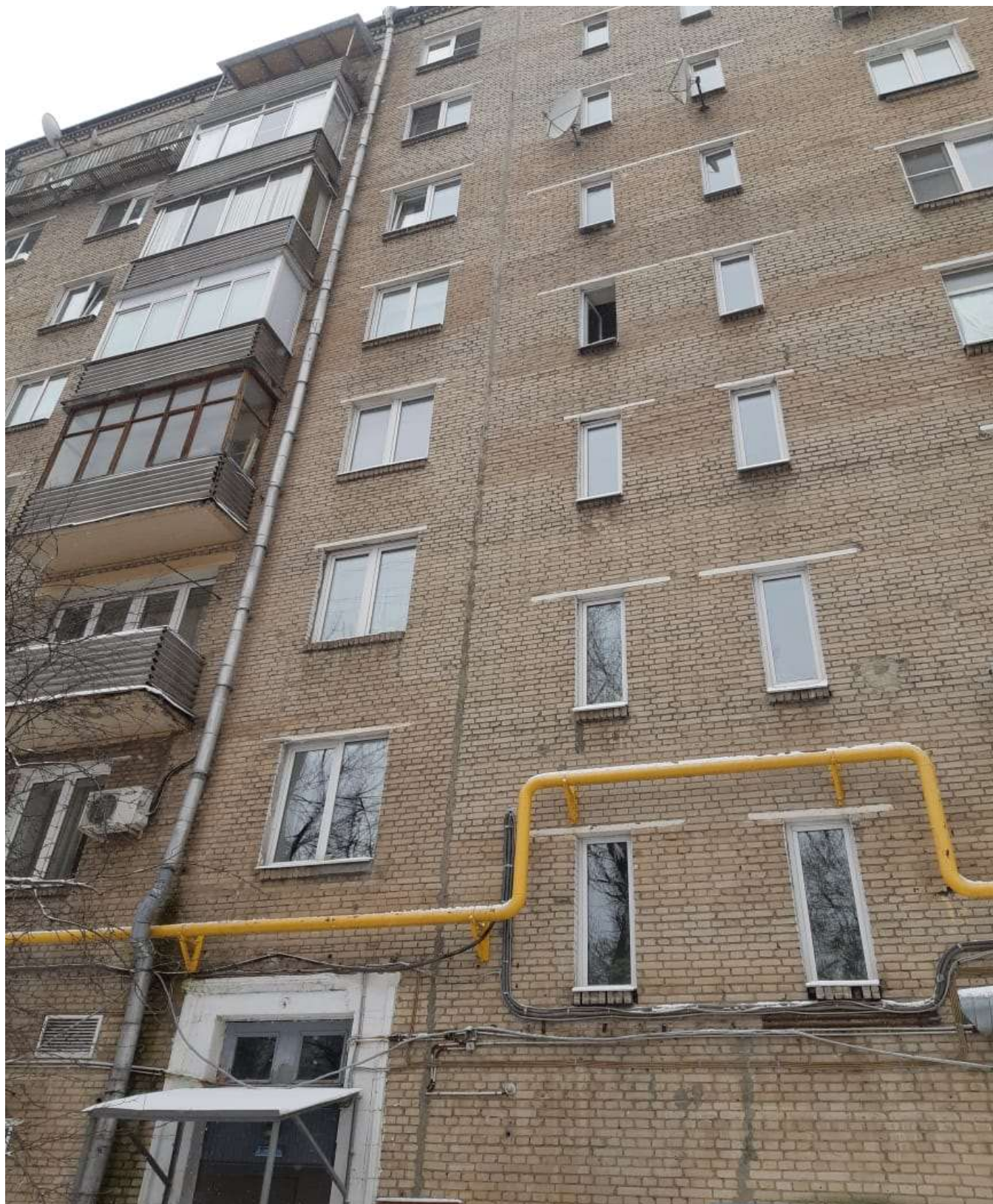
Фото 24. Общий фасада здания
