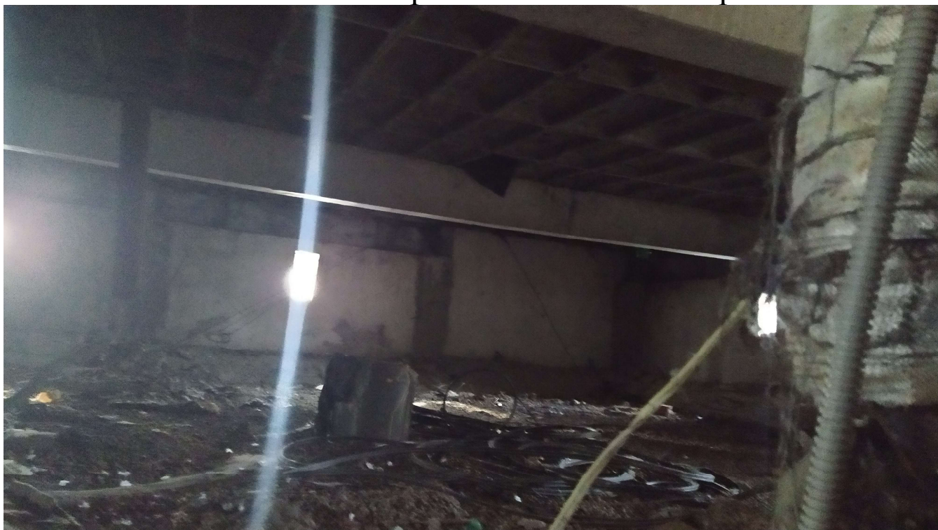
Фото 38. Общий вид состояния кровли
