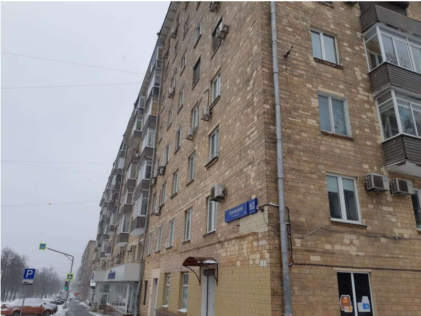
Фото 15. Общий вид фасада здания.
