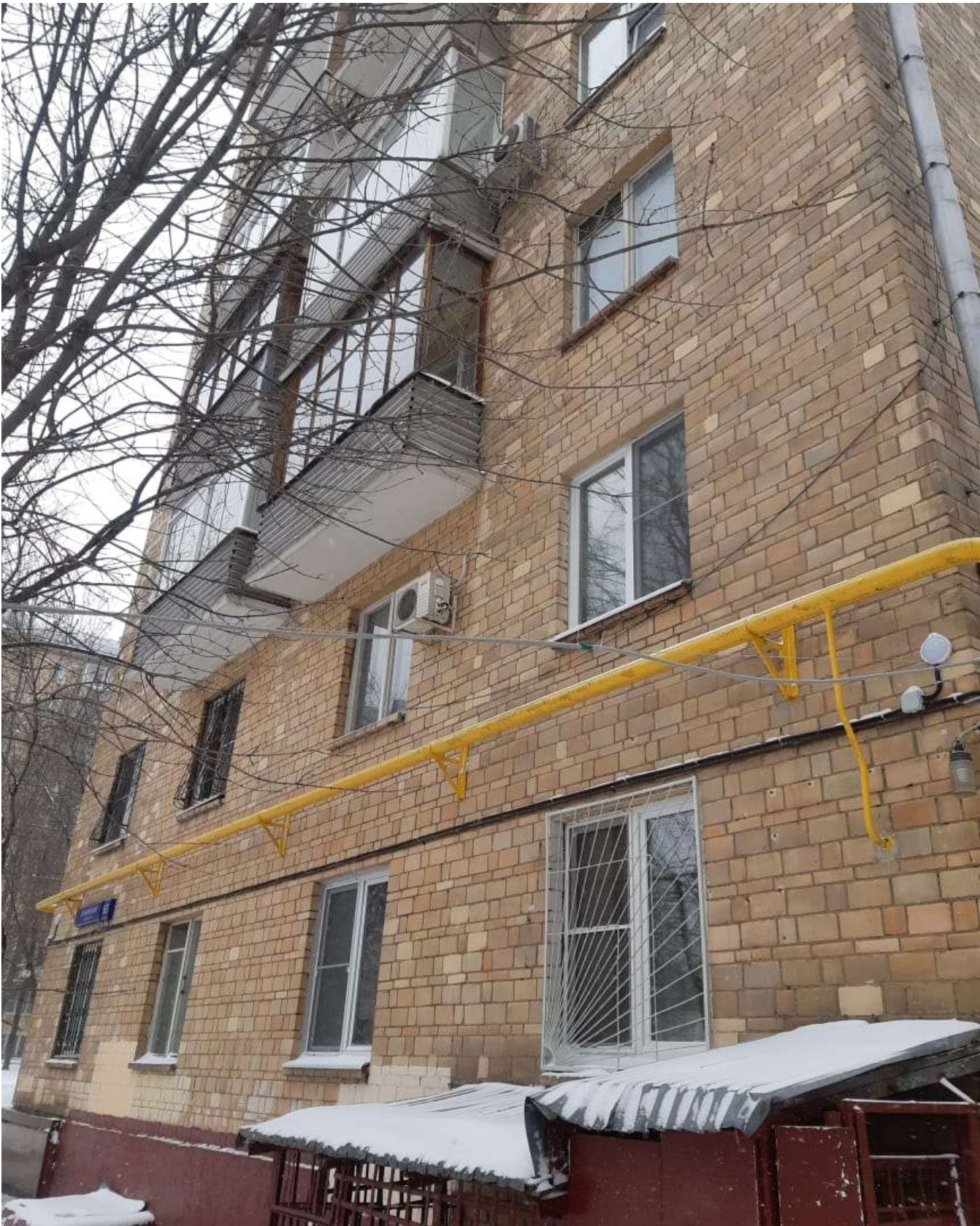
Фото 22. Общий вид фасада здания
