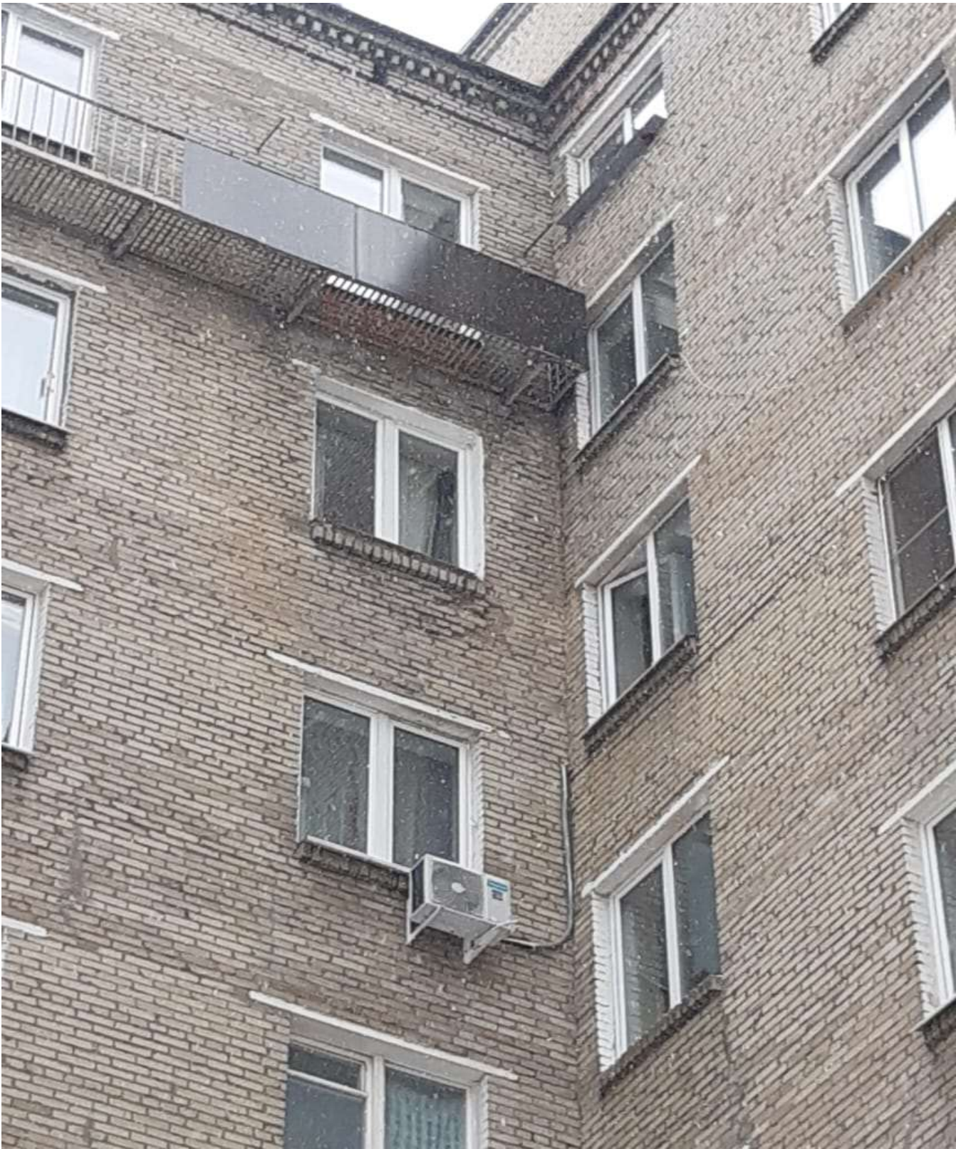
Фото 25. Общий вид фасада здания
