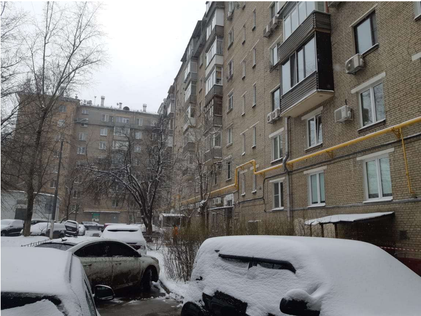
Фото 2. Общий вид фасада здания
