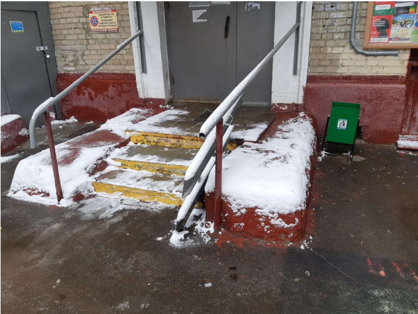
Фото 30. Общее состояние входных групп
