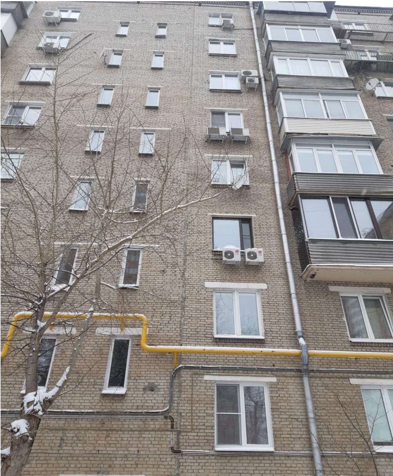
Фото 28. Общий вид фасада здания
