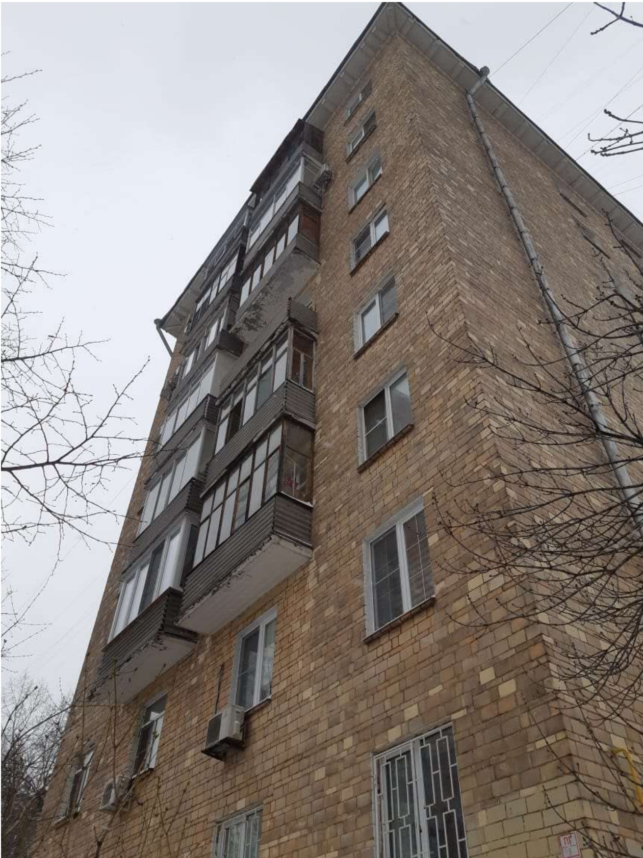
Фото 3. Общий вид фасада здания
