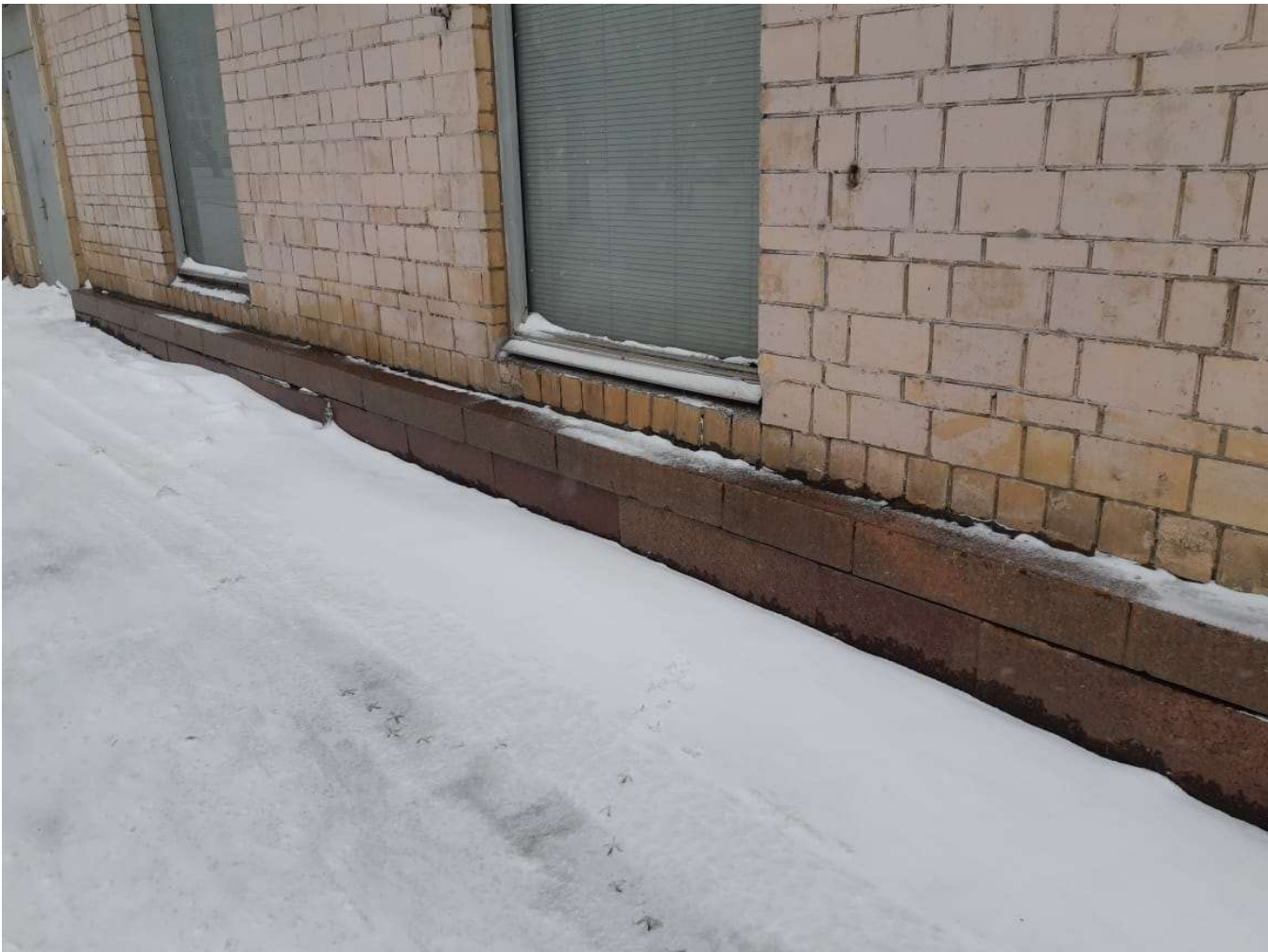
Фото 34. Общий вид отмостки здания
