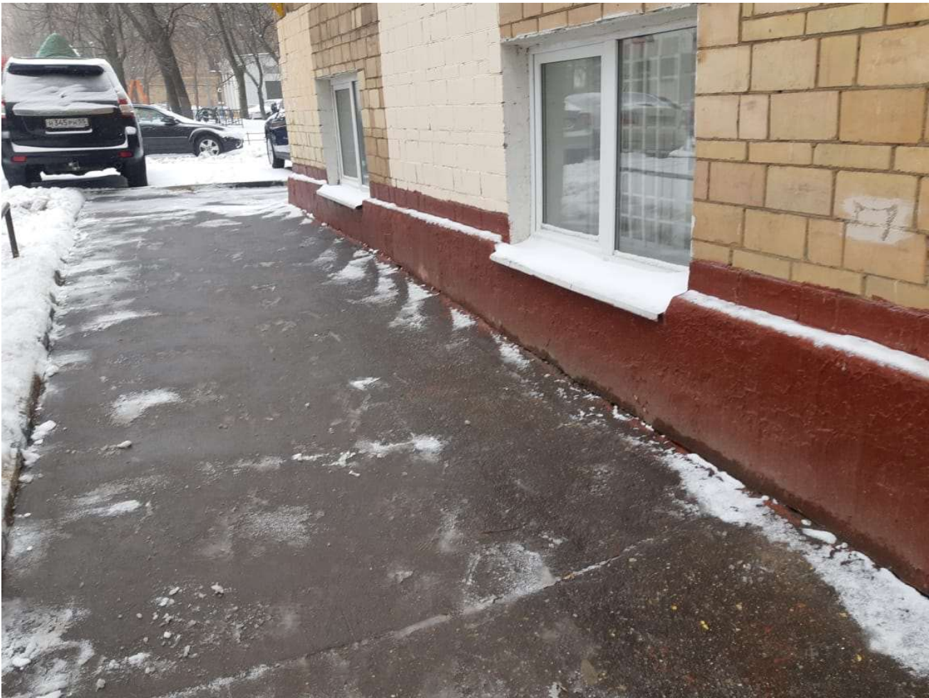
Фото 32. Общий вид отмостки здания
