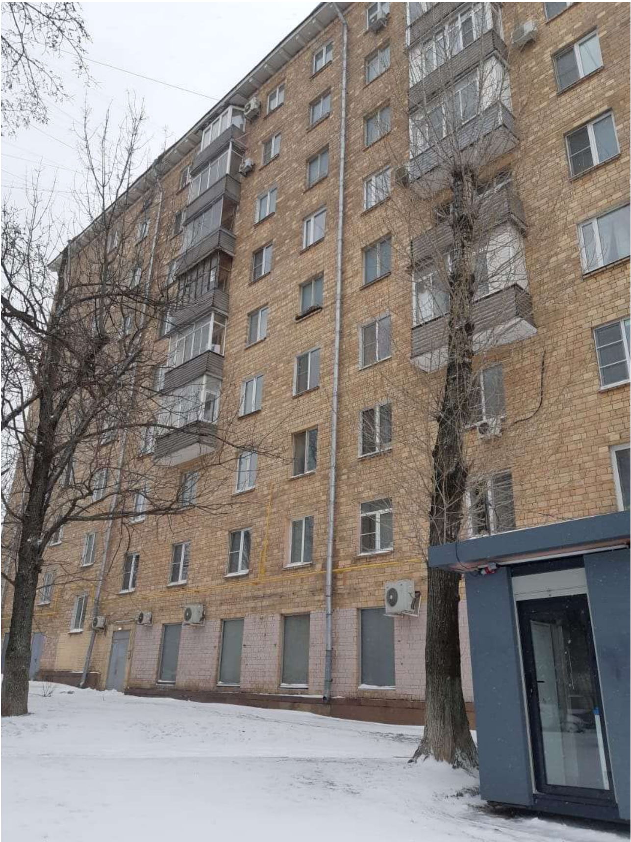
Фото 5. Общий вид фасада здания
