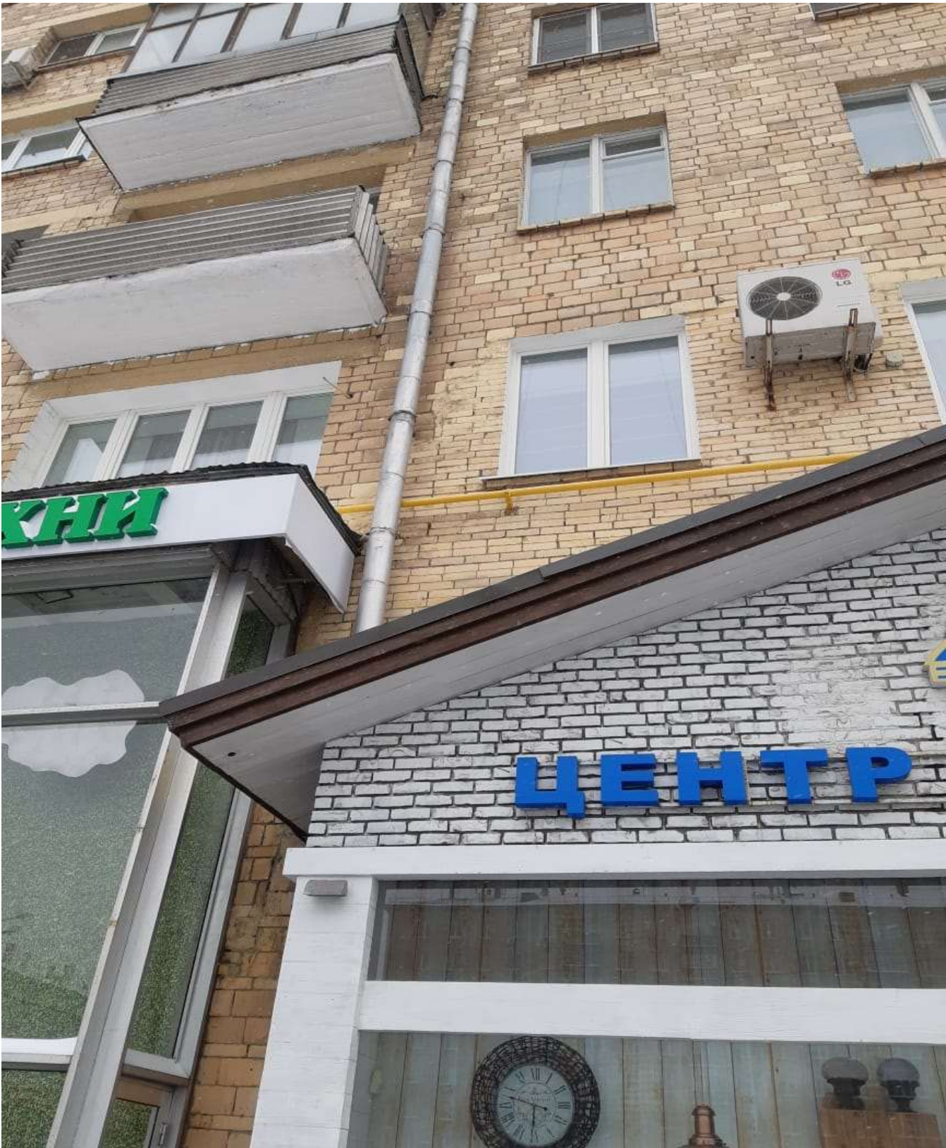
Фото 10. Состояние наружного водостока
