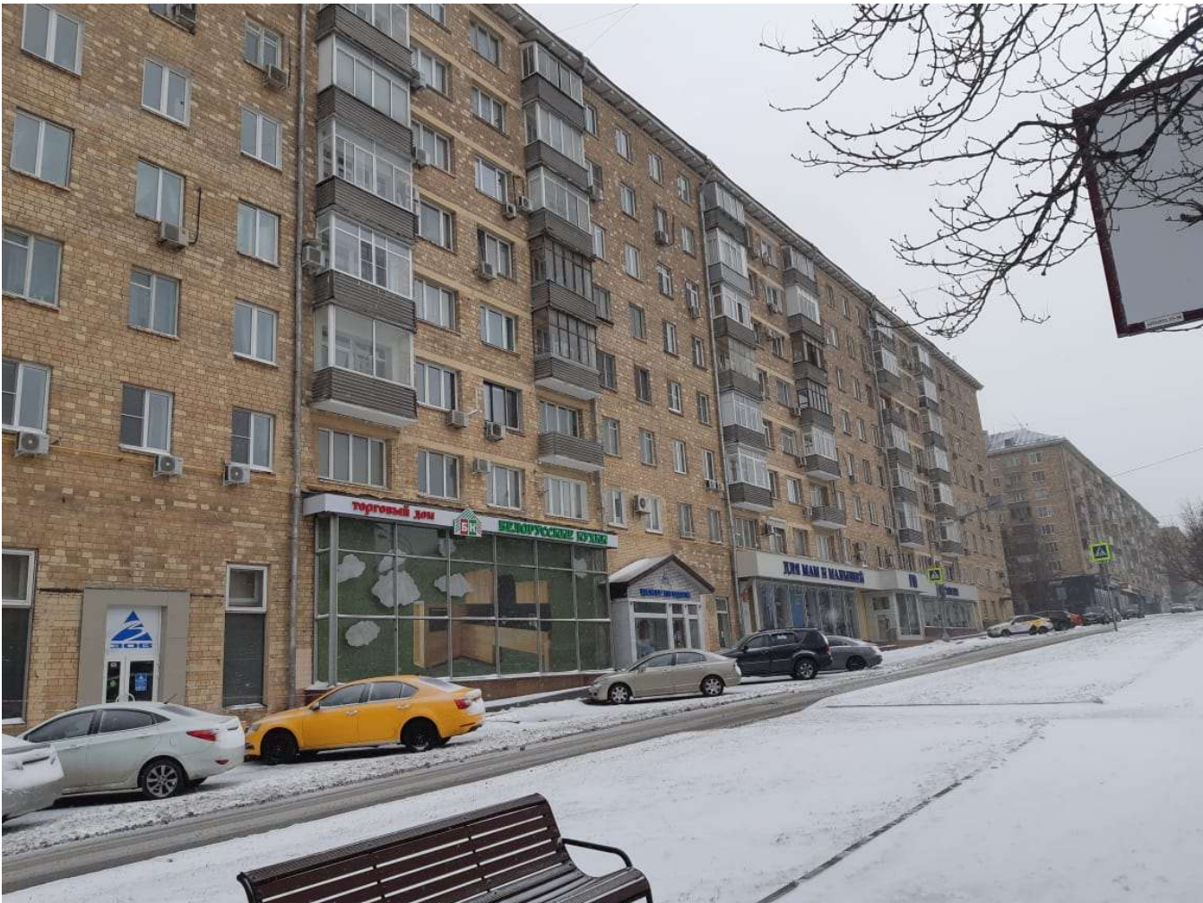
Фото 4. Общий вид фасада здания
