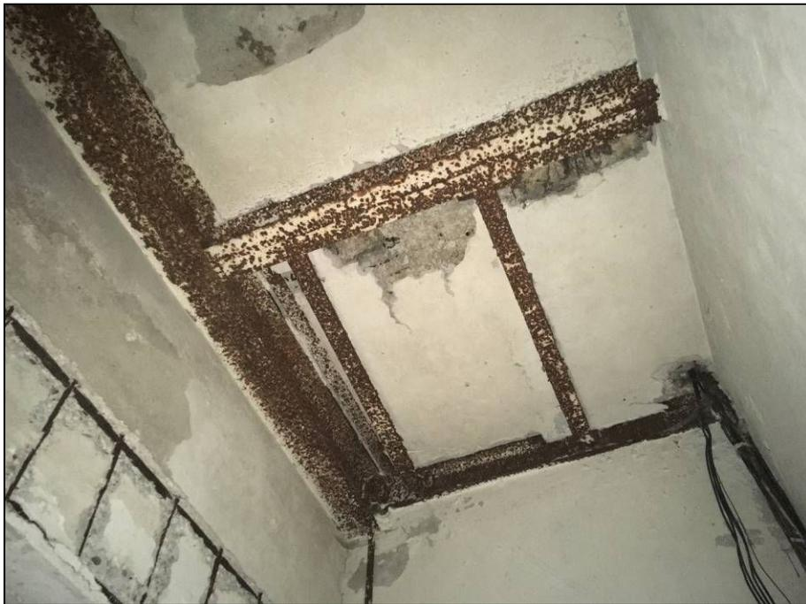
**Фото 28.** Поверхностная коррозия конструкций из стального проката, на которые опирается монолитное перекрытие дна лифтовой шахты.
