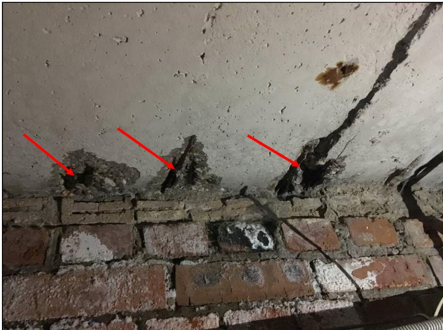
**Фото 26.** Разрушение защитного слоя плит перекрытия в подвале обследуемого здания.
