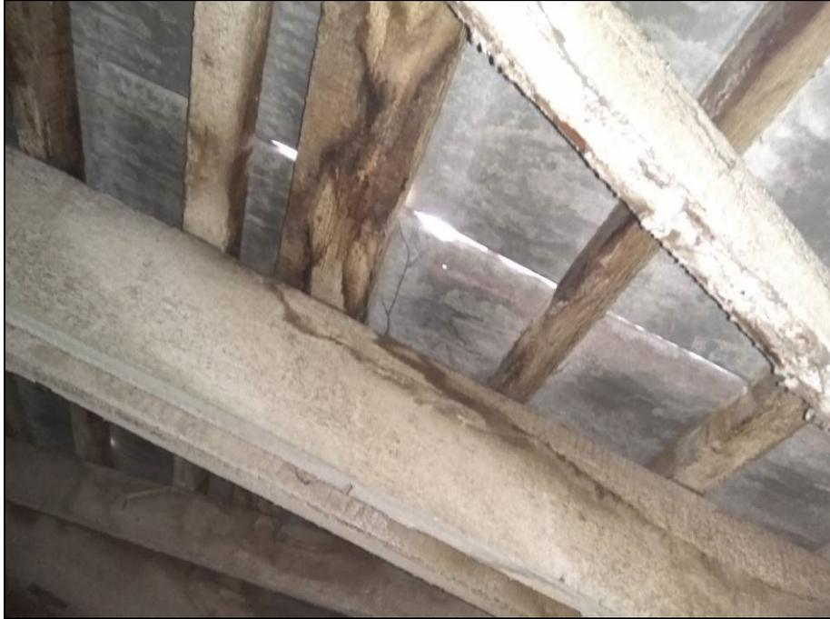
**Фото 21.** Стропила и обрешётка крыши со следами протечек.
