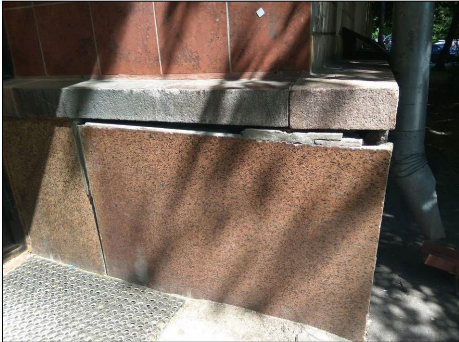
**Фото 9.** Отслоение отделочного слоя из гранитной плитки.
