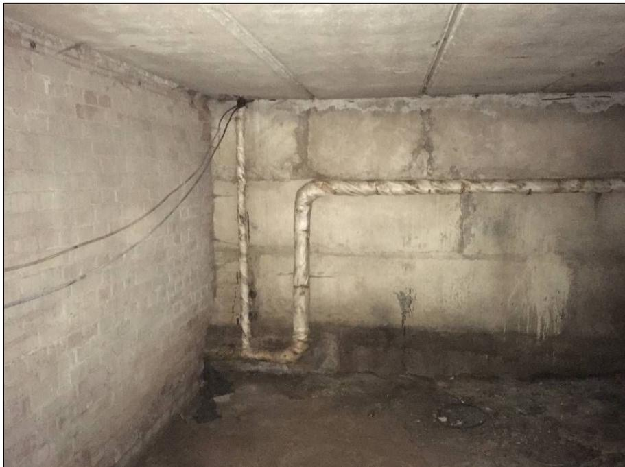
**Фото 24.** Наружные стены фундамента из блоков ФБС в подвале. Перекрытие подвала - сборное железобетонное из многопустотных плит.
