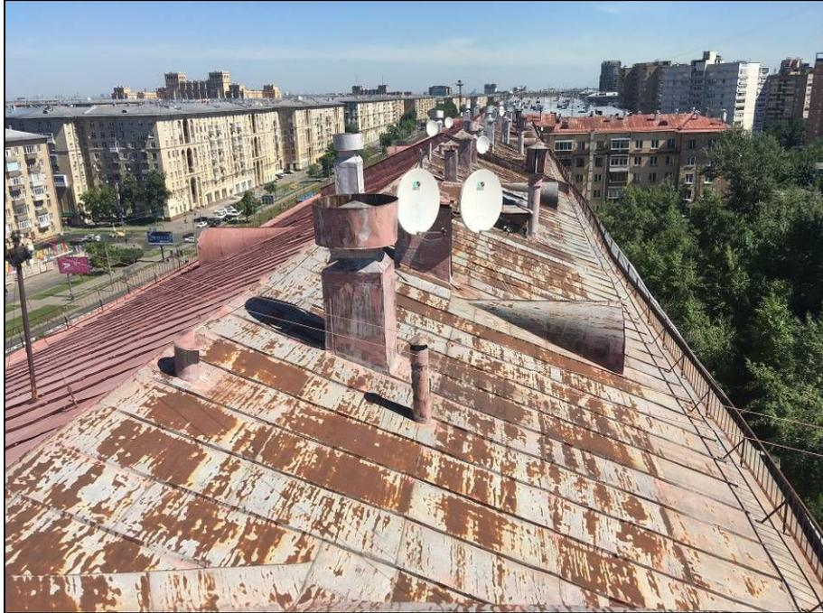
**Фото 17.** Общий вид кровли. Со стороны Ленинского проспекта железо окрашено, со стороны двора – нет, в результате - коррозия.
