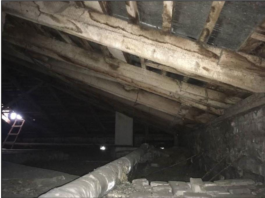
**Фото 23.** Опираие стропил на мауэрлат из досок. Следы протечек.
