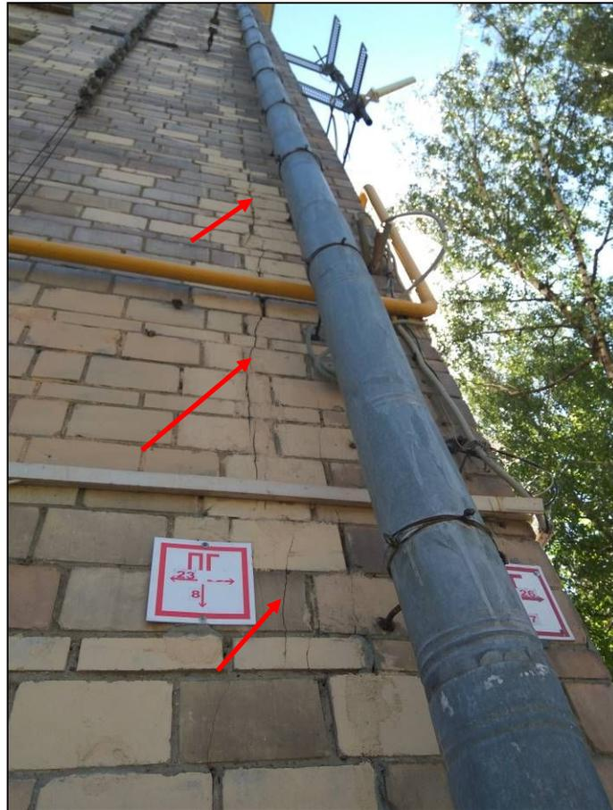
**Фото 7.** Характерные трещины на северо-западном фасаде.
