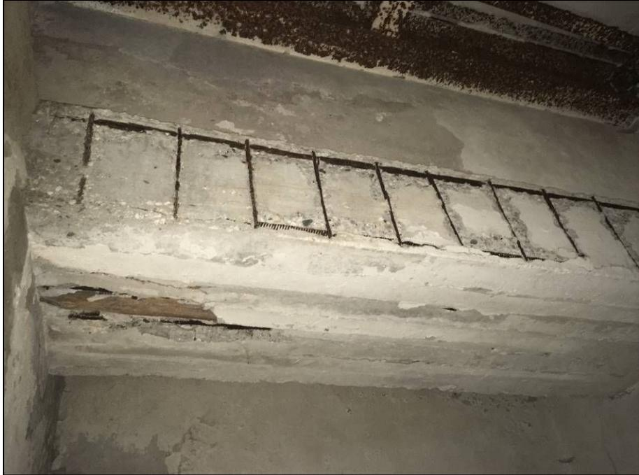
**Фото 25.** Разрушение защитного слоя балок в подвале обследуемого здания.
