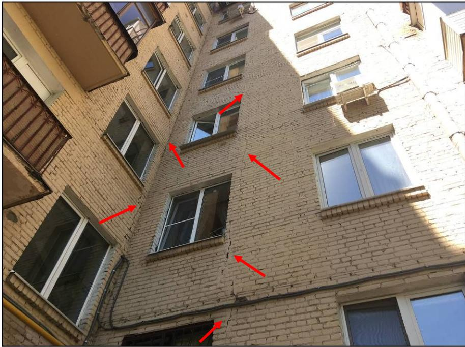
**Фото 11.** Характерные трещины в кладке из силикатного кирпича на юго-восточном фасаде (во дворе).
