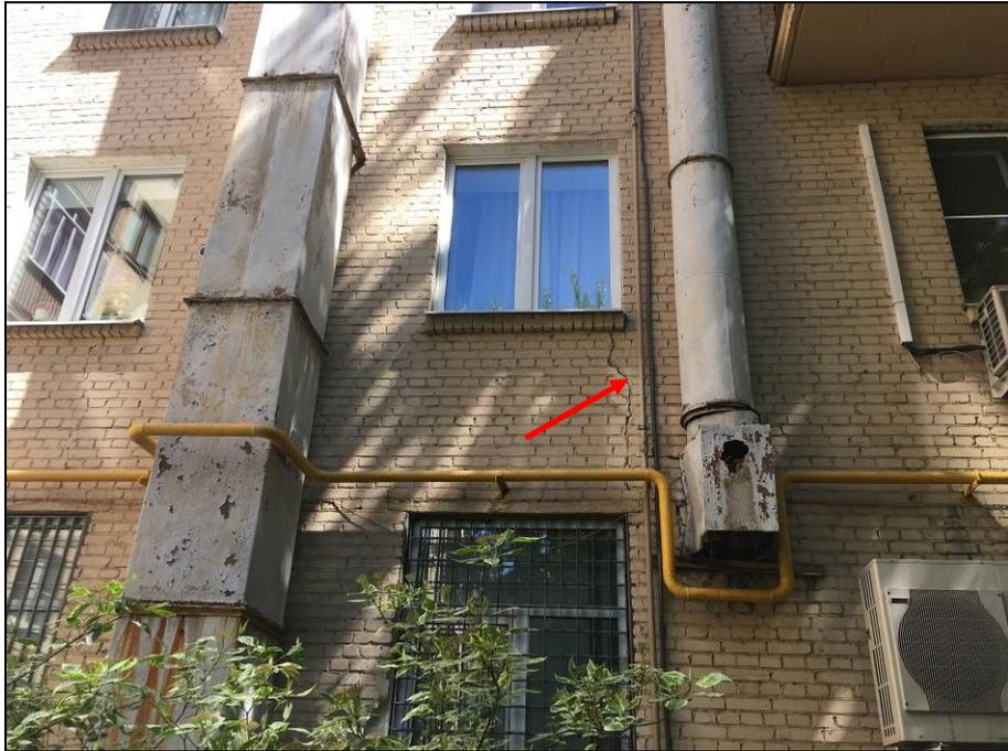
**Фото 13.** Характерная трещина в кладке на юго-восточном фасаде (во дворе).
