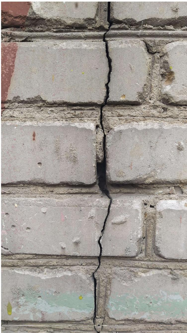
Фото 6. Трещина фасада здания у дверного проема по адресу: г. Москва, Ленинский проспект, д. 74.
