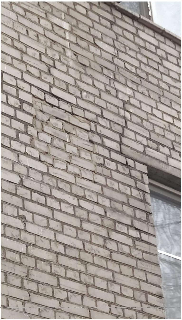
Фото 7. Трещина фасада здания у оконного проема по адресу: г. Москва, Ленинский проспект, д. 74.
