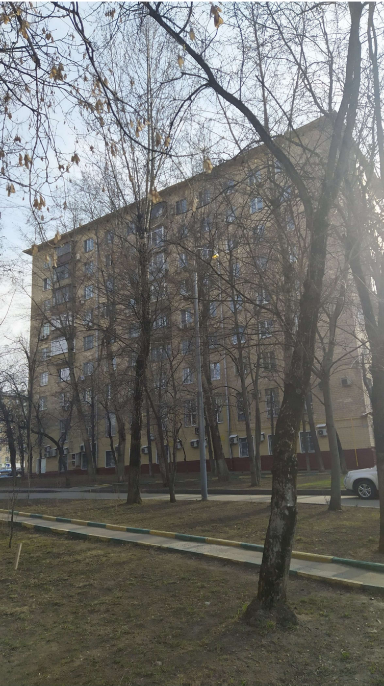
Фото 1. Общий вид на здание по адресу: Москва, Ленинский проспект, д.78.
