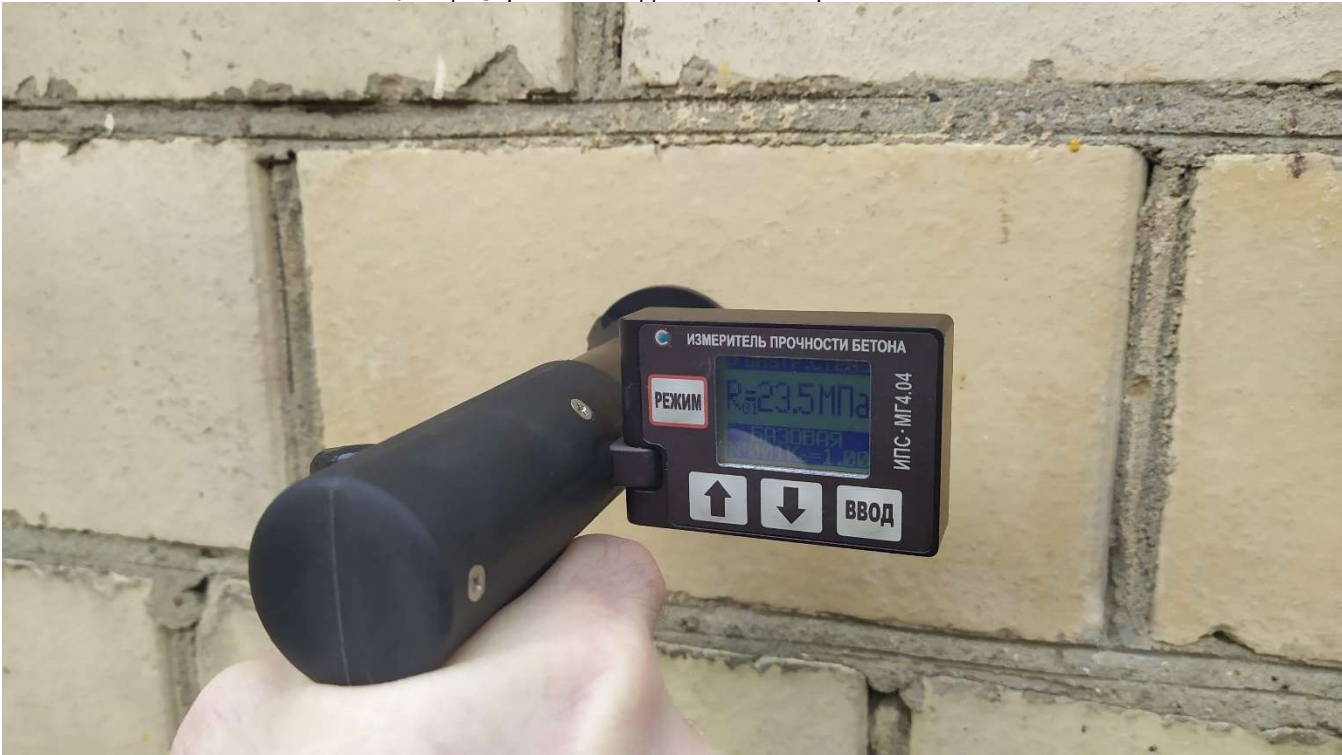
Фото 20. Измерение прочности бетона здания по адресу: г. Москва, Ленинский проспект, д. 78.
