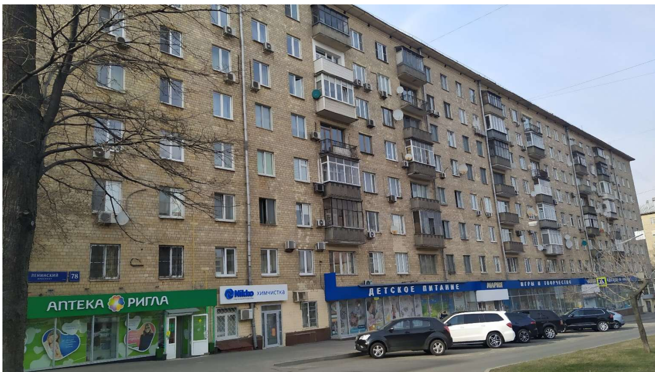
Фото 23. Общий вид здания по адресу: г. Москва, Ленинский проспект, д. 78.
