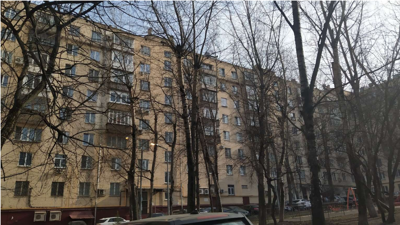
Фото 2. Общий вид на здание по адресу: Москва, Ленинский проспект, д.78.
