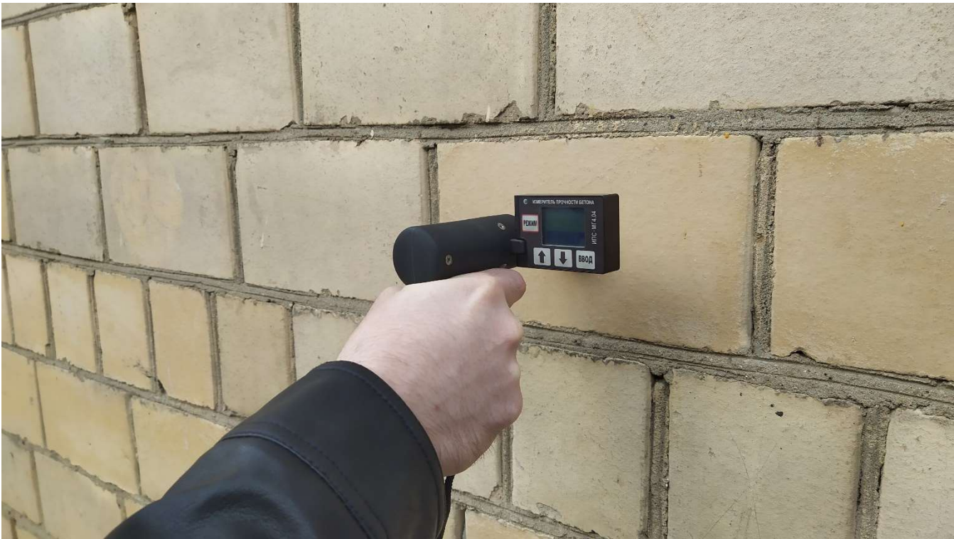
Фото 19. Измерение прочности бетона здания по адресу: г. Москва, Ленинский проспект, д. 78.
