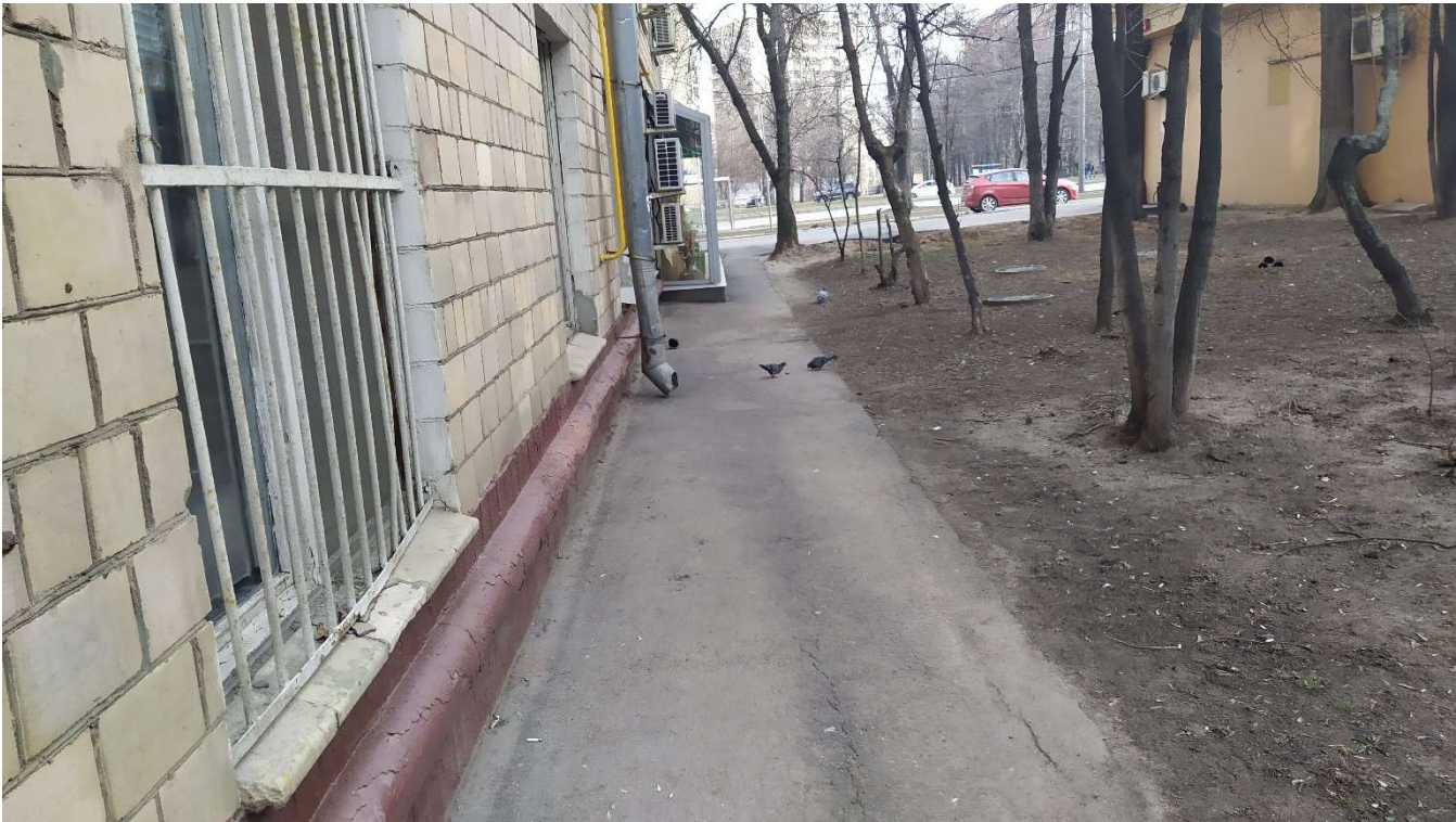
Фото 21. Общий вид отмостки здания по адресу: г. Москва, Ленинский проспект, д. 78.
