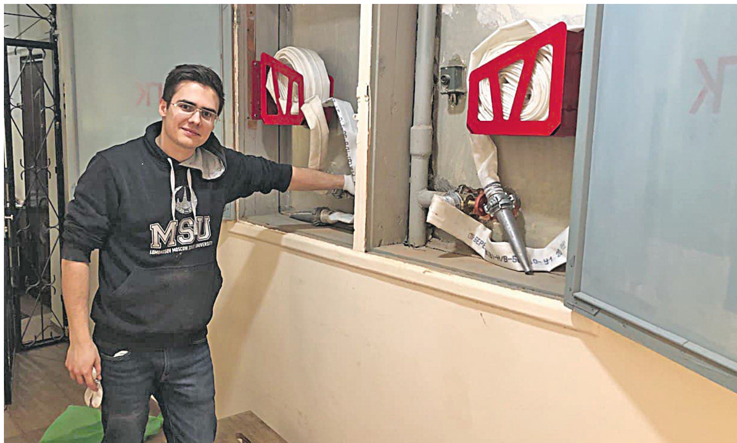
Кирилл Чиркин на фоне образцового пожарного шкафа.
